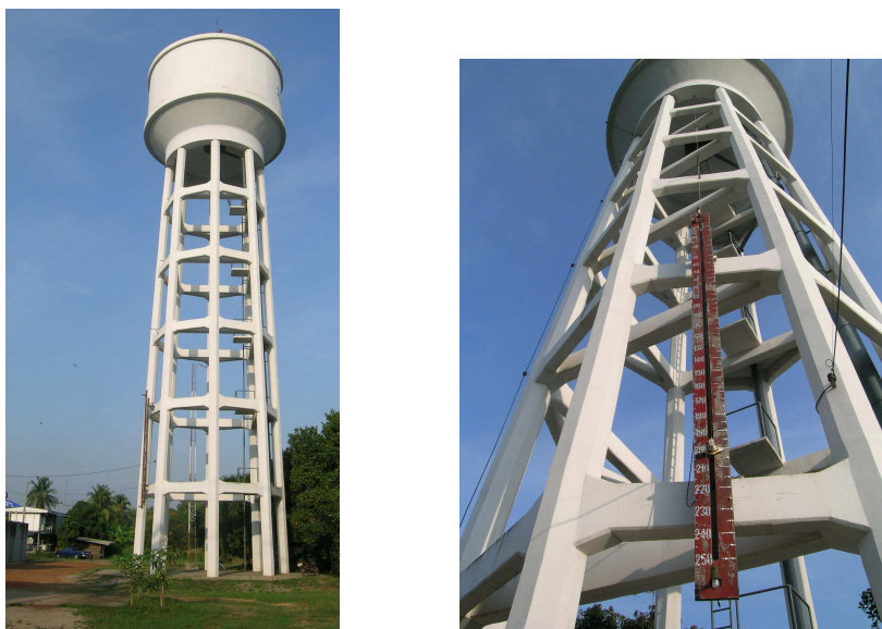
Slika 11.26: Vodni stolp s preprosto napravo za merjenje količine vode
