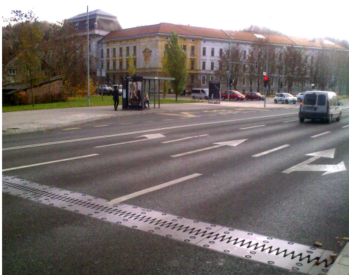
Slika 13.8: Na cestnih mostovih pogosto opazimo prekinitve cestišča.
