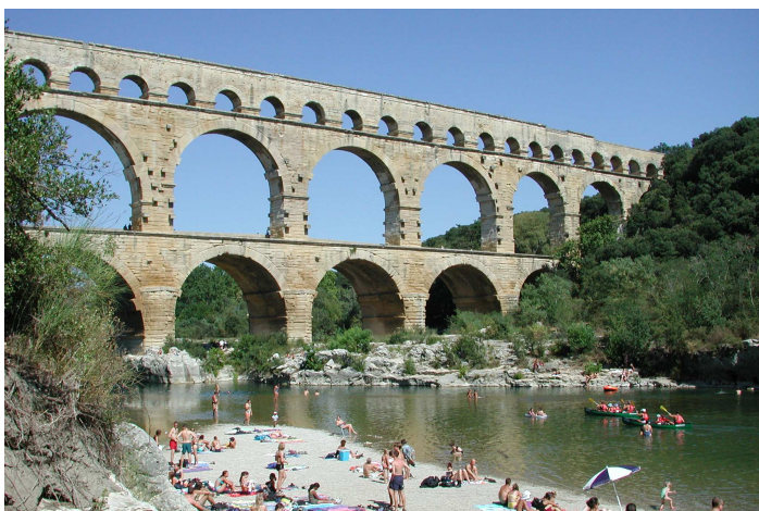
Slika 6.8: 266 m dolg in 49 m visok most preko reke Gard v Provansi (Pont du Gard) so zgradili Rimljani leta 19 pr. n. š. kot akvadukt in že dva tisoč let kljubuje času.
